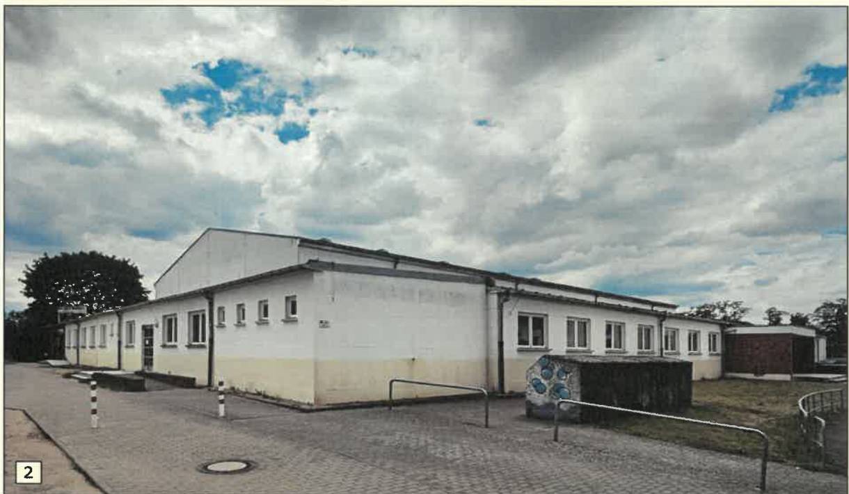
Bilder 1 und 2: Sporthalle „Friedrich-Franz-Gymnasium“ mit Blick von Nordosten (Bild 1) und von Osten (Bild 2). Dacheindeckung der randlichen Anbauten mit asbesthaltiger Dachpappe (s. auch Bilder 5 und 6).
