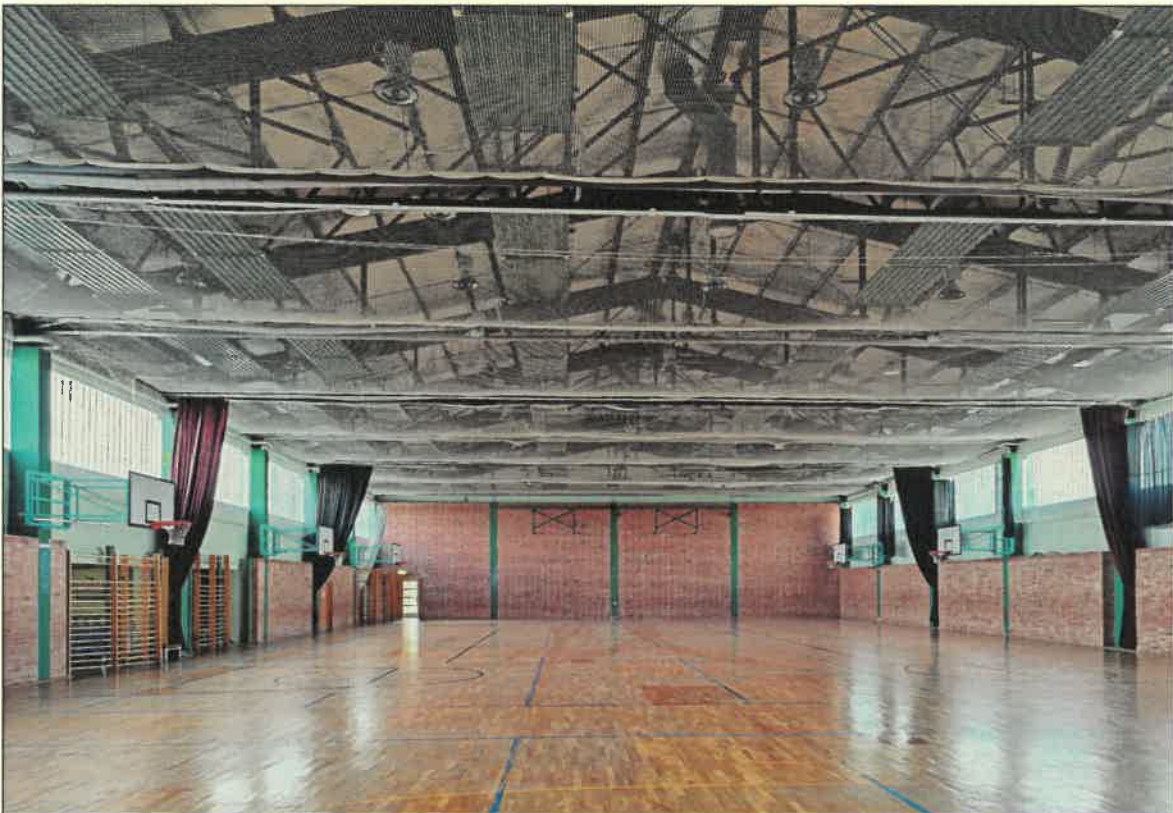
Bild 12: Zentraler Bereich, große Halle – Deckenbereich mit Deckenheizplatten mit KMF-Dämmauflage und Heizleitungen mit Dämmung aus Mineralwolle „Kamilit“. Fußbodenaufbau mit Holzparkett (Altholz A IV) und asbesthaltigen Sperrpappen „Ruberoid“ (s. auch Bild 13).
