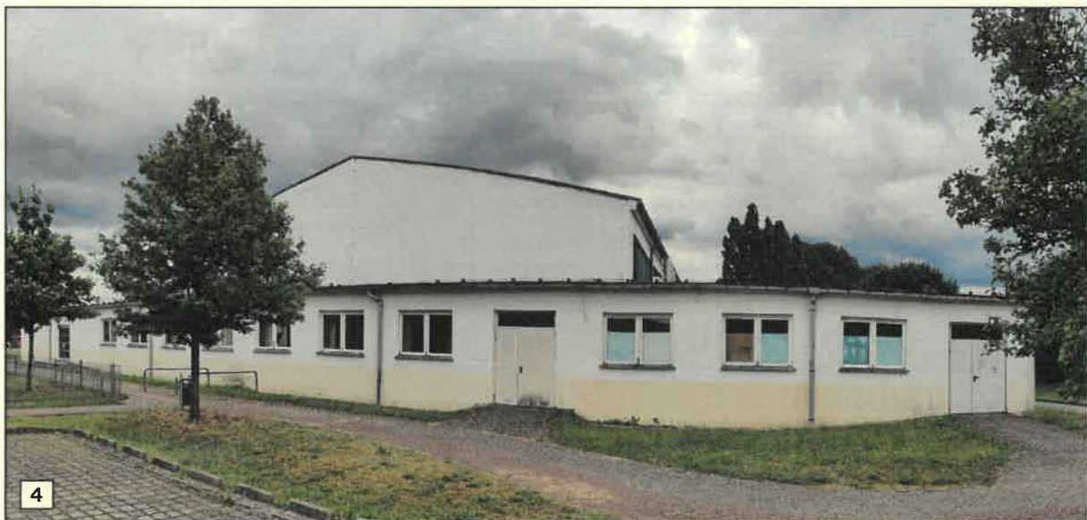
Bilder 3 und 4: Sporthalle „Friedrich-Franz-Gymnasium“ mit Blick von Süden (Bild 3) und von Westen (Bild 4). Dacheindeckung der randlichen Anbauten mit asbesthaltiger Dachpappe (s. auch Bilder 5 und 6).
