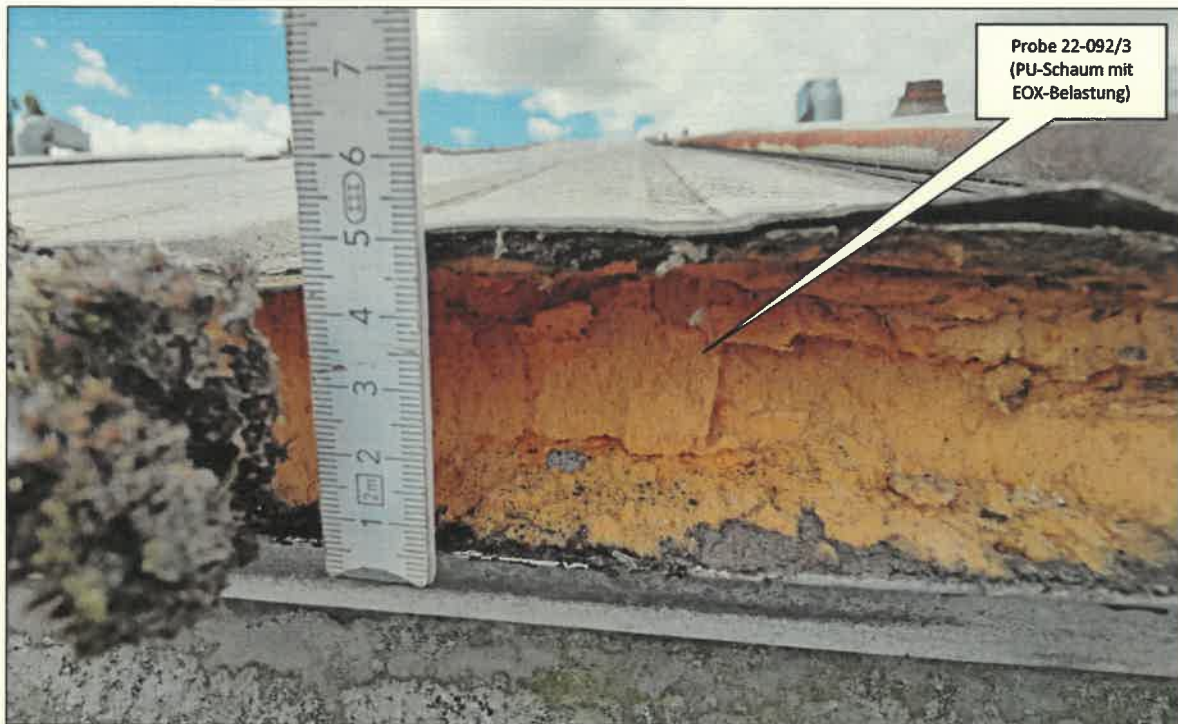
Bild 7: Sporthalle, Zentralbereich – Dacheindeckungen mit Sandwichelementen aus EOX-belastetem PU-Schaum zwischen Profilblechen.
